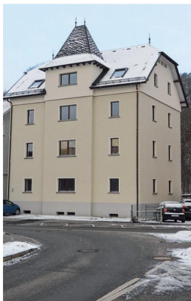
Danach: Das Fachwerk unter dem Giebel des Walmdachs ist hinter einer Isolierung verschwunden. FOTO: MICHAEL HESCHELER
