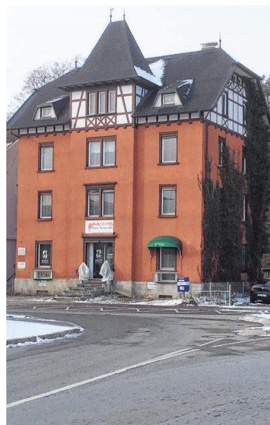
Vorher: Bis zur Sanierung hatte das Haus an der Fürst-Wilhelm-Straße 4 hat ein markantes Fachwerk. FOTO: SCHÖTTGEN
